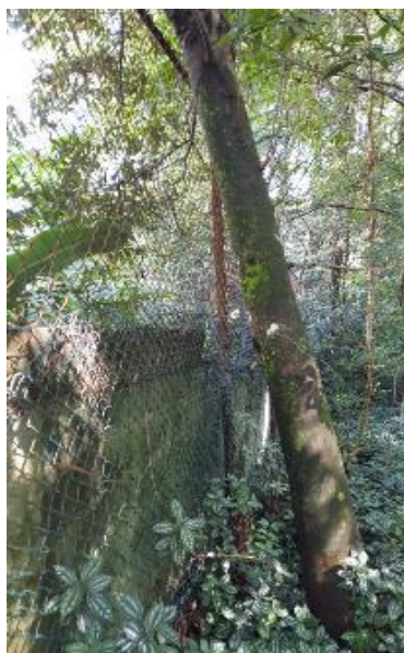
Figura 18: Indivíduo arbóreo da espécie Cinnamomum zeylanicum (caneleira) que ficou apoiado no muro no limite do parque. Laudo 2021_02_08_EU
