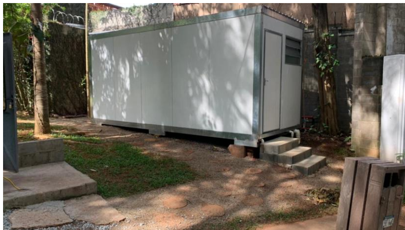
Figura 24: Container de vestiários instalado no parque.
